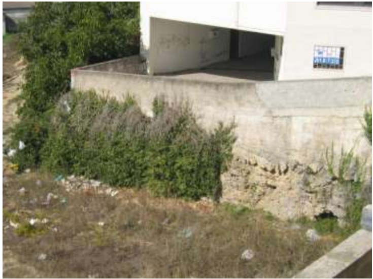
Cano Real do Norte, vendo-se a saída para o Poço d' El-Rei.
