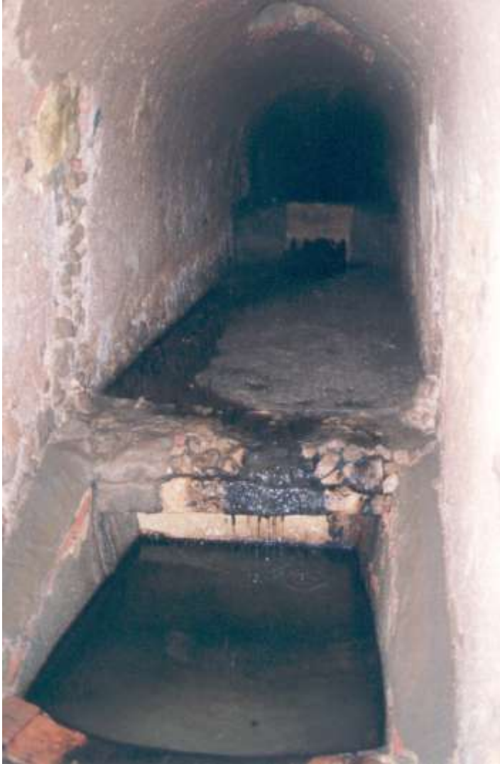
Cano Real do Norte, intersector transversal, com tanques de decantação
